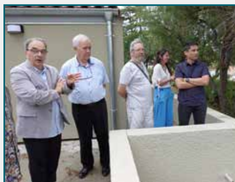
Visite du Maire de Limoux à l'EANM de Limoux pour la fin des travaux des 12 appartements
